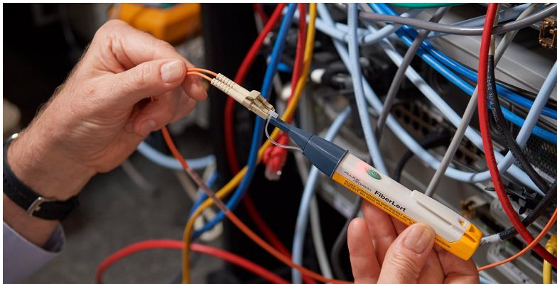
Überprüft Polarität und Funktion der Patchkabel.
